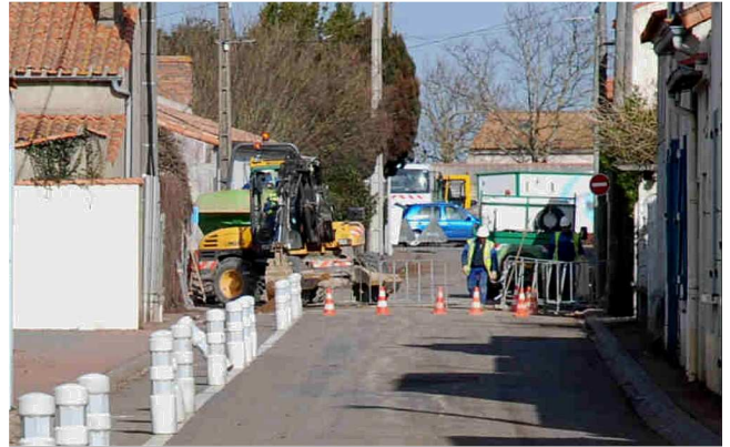
Avec ces travaux, la sécurisation des piétons sera améliorée.
